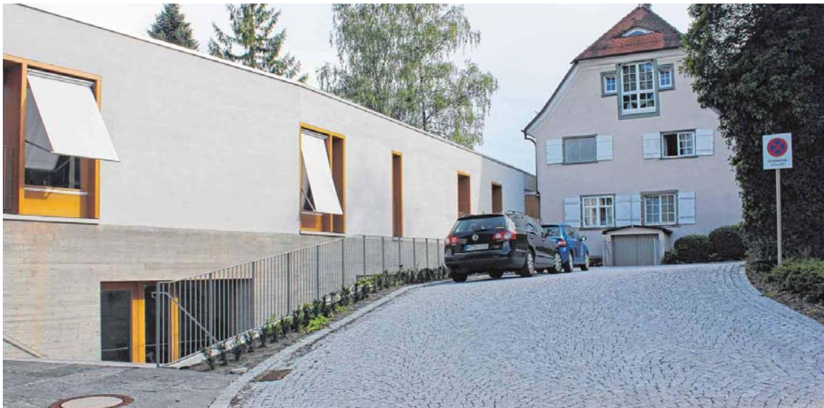
Dank des Erweiterungsbaus kann das Hospiz jetzt insgesamt acht schwerstkranke und sterbende Menschen aufnehmen.
