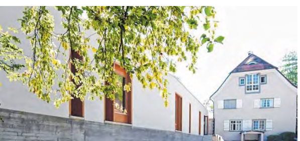
Die Fertigstellung des modernen Anbaus an das Hospizzentrum Haus Brög zum Engel wird gefeiert.
